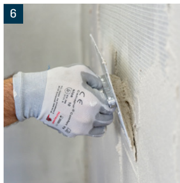
6 Alternativ Veroboard® AllStar Kombi-Mörtel als Oberputz auftragen und nach Wunsch gestalten
