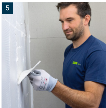
5 Wandoberfläche mit Veroboard® AllStar Silikatspachtel glätten
