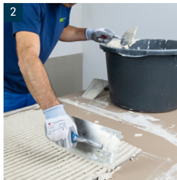
2 Veroboard® AllStar Kombi-Mörtel mit Zahntraufel auf Platte oder auf die Wand auftragen
