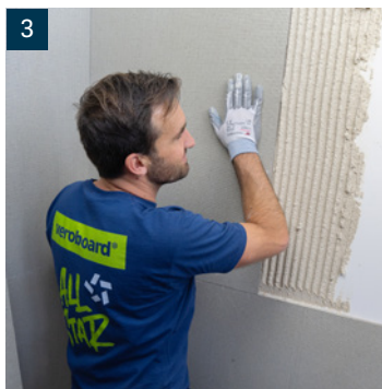
3 Platten im Versatz und lotgerecht mit dem Untergrund verkleben
